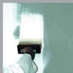
Application of primer
